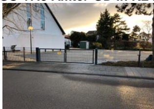
Unser Parkplatz ist fertig!
